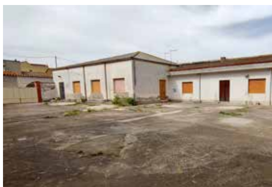
2021: prima dei lavori
